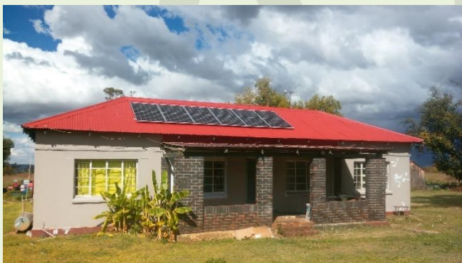
改修中の農場住宅
